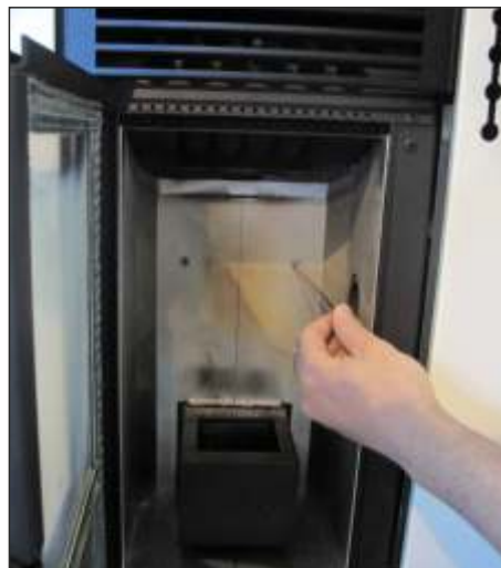
3. Odvijte dva vijka limova ložišta
